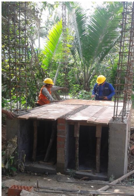
Armado del techo de las cámaras composteras
